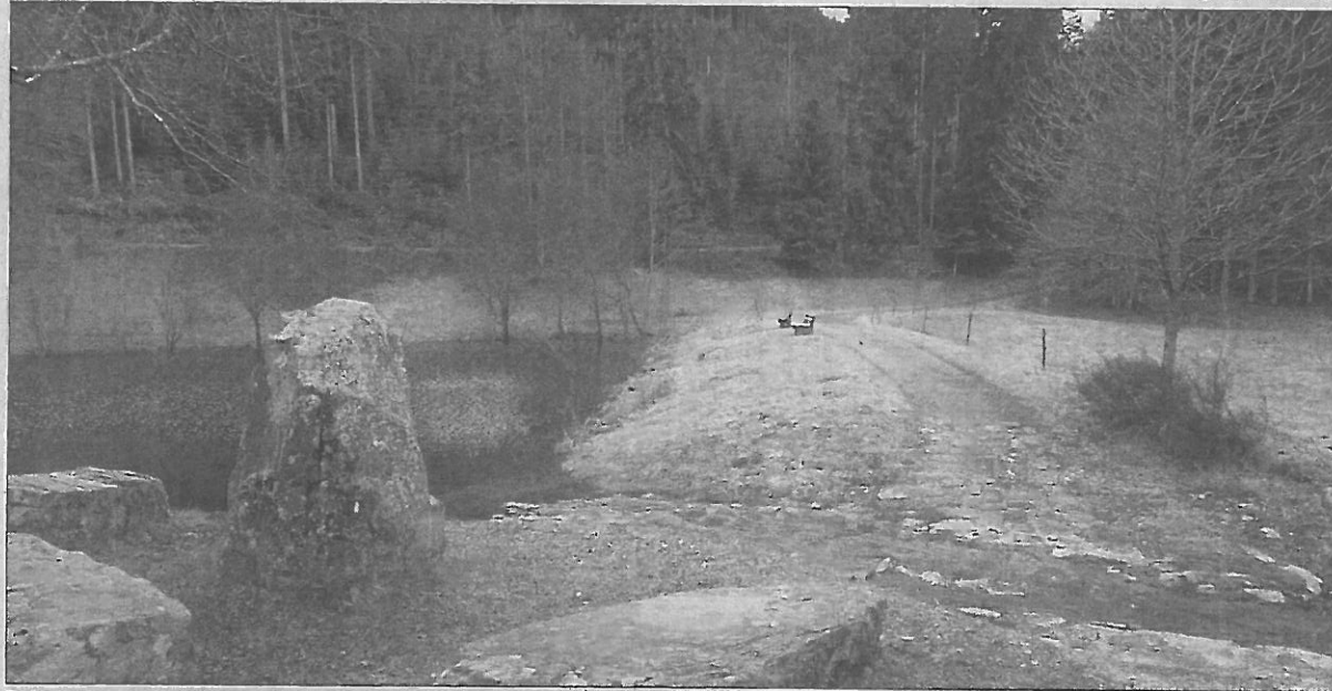
Beim Damm am Märteweier soll ein Steg oder eine Hängebrücke errichtet werden.
